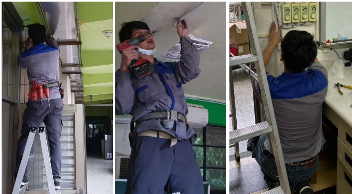
施工人員穿著制服
