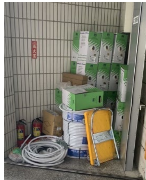
施工材料整齊擺放
